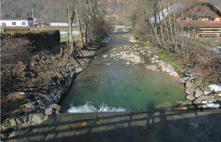
Foto 3: K33, Blick in Fliessrichtung des Rümliigs, Schwelle unterhalb der Rümliigbrücke
