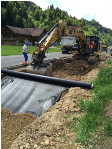
Vorarbeiten am neuen Rad- und Gehweg.
