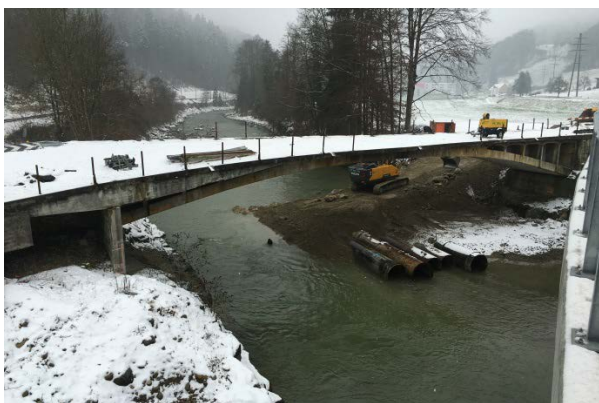
Rückbau der alten Langnauerbrücke
