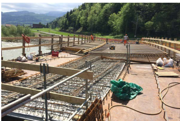
Bau der neuen Langnauerbrücke
