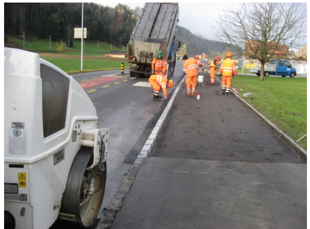
Arbeiten am neuen Rad- und Gehweg
