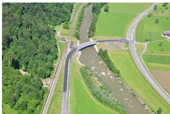
Luftaufnahme der neuen Langnauerbrücke
