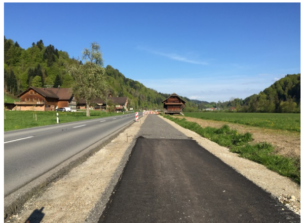
Der neue Rad- und Gehweg kurz vor der Fertigstellung.
