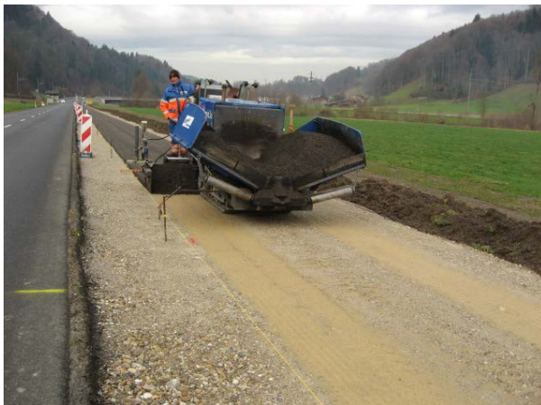
Der neue Rad- und Gehweg entsteht
