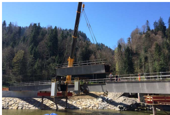
Einbau der Stahlkastenträger
