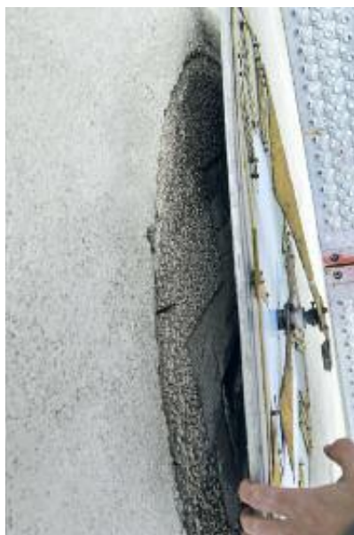
Abb. 38 Der historische dunkle und strukturierte Verputz wurde noch unter dem späteren Putz gefunden.
