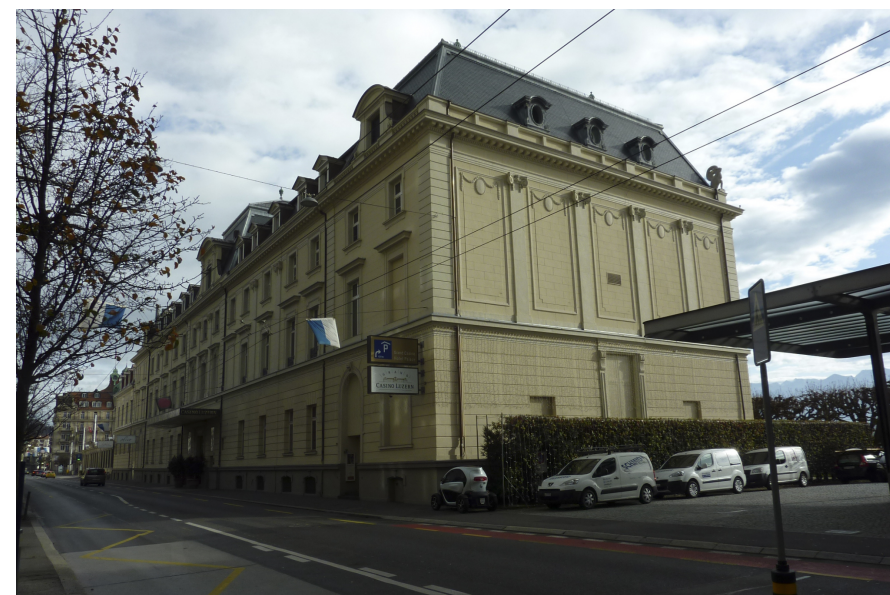
Haldenstrasse 6, Casino Luzern, Ansicht von NW (Aufnahme 2015)
