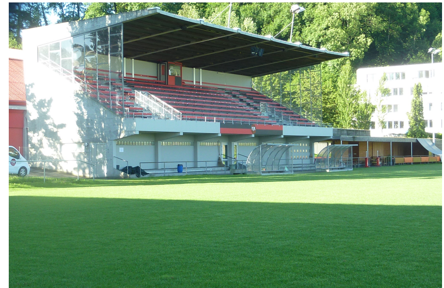
Eisfeldstrasse 3, Tribüne Sportklub Kickers, Ansicht von N (Aufnahme 2016)
