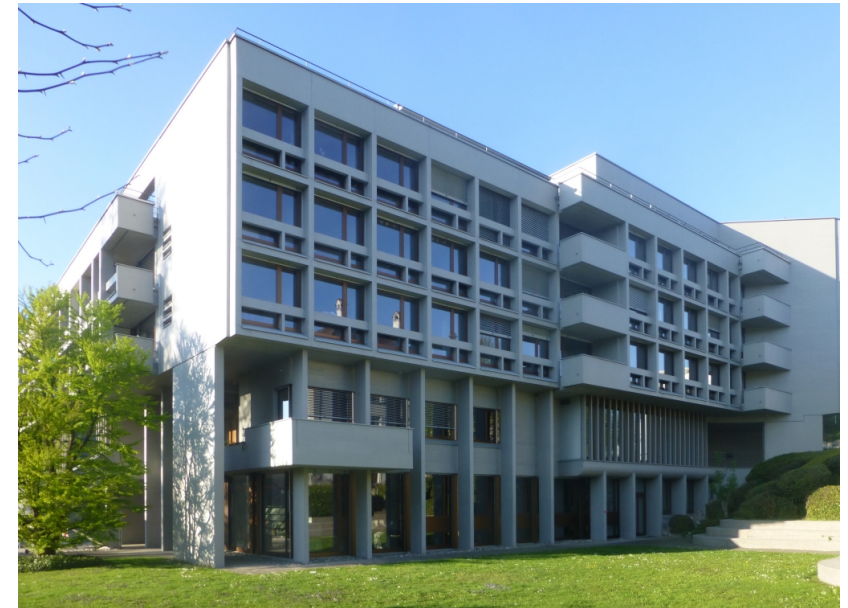
Adligenswilerstrasse 15, Priesterseminar, Ansicht von S (Aufnahme 2017)
