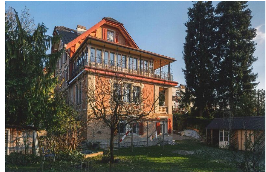
Kapuzinerweg 25, ehem. Pension Sommerau, Ansicht von NW (Aufnahme 2017)
