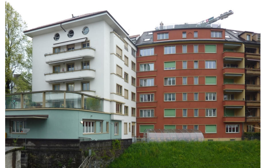
Claridenstrasse 9, Ansicht von SW (Aufnahme von 2017)
