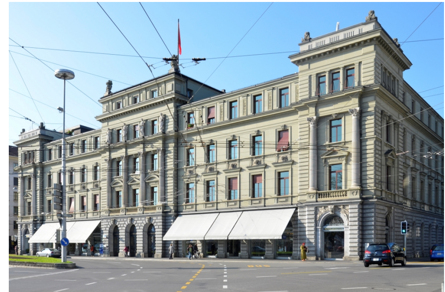
Schweizerhofquai 6, ehem. Verwaltungsgebäude der Gotthardbahngesellschaft, Ansicht von SO (Aufnahme 2011)
