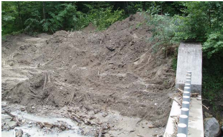
Räumungs- und Reinigungsarbeiten
