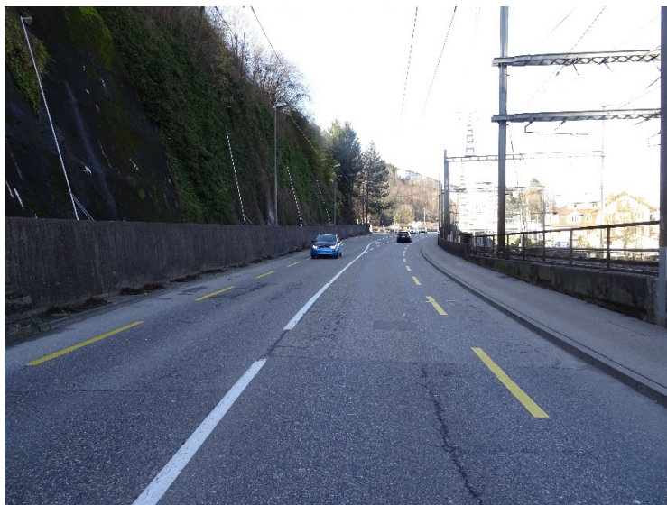
Foto 6: Standort Hauptstrasse in Blickrichtung Seetalplatz mit bestehender Stützmauer und Spritzbetonmauer (linker Bildrand)
