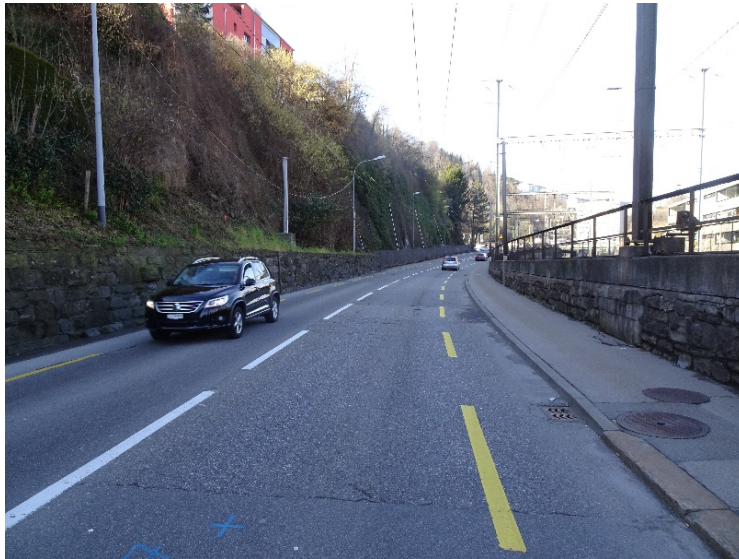
Foto 5: Standort Hauptstrasse in Blickrichtung Seetalplatz mit bestehender Blocksteinmauer (linker Bildrand)
