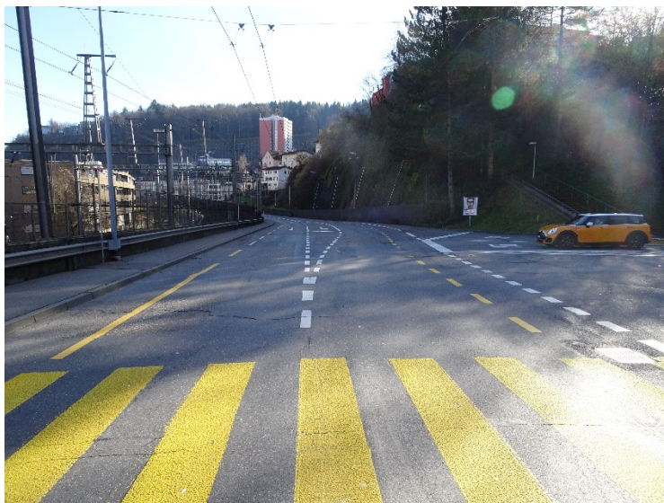
Bild 9: Standort Hauptstrasse in Blickrichtung Luzern mit bestehender Spritzbetonmauer und Einmündung Fluhmühlerain
