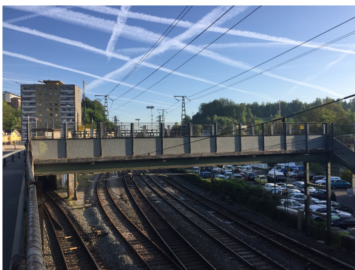
Foto 3: Standort Hauptstrasse in Blickrichtung Seetalplatz mit SBB-Passerelle
