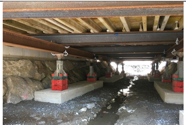
Lehrgerüst für Brückenplatte
