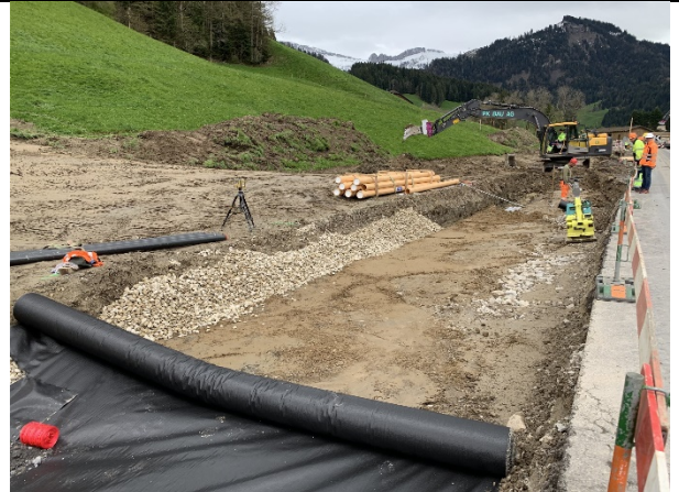
Unterbau der Strassenverbreiterung
