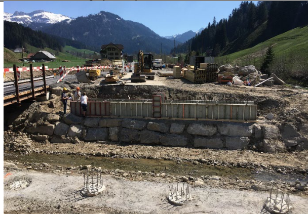
Schalung Brückenwiderlager
