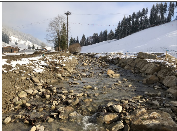
Neues Bachbett Rämisbach
