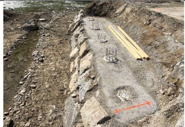
Fertige Pfähle im Brückenwiderlager
