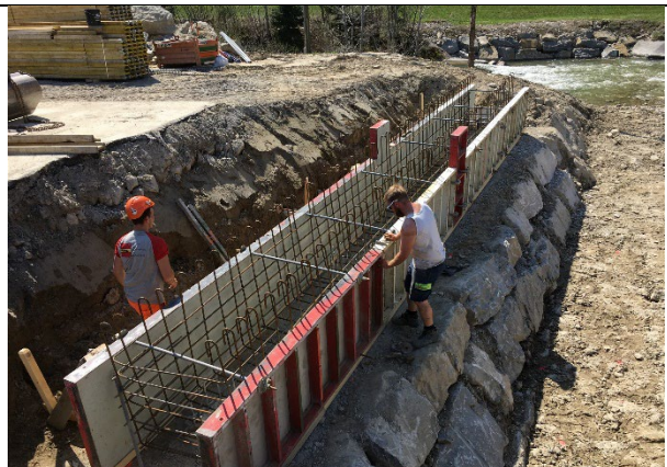
Schalung und Bewehrung Brückenwiderlager
