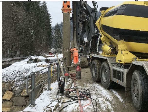
Pfahlarbeiten Brückenwiderlager
