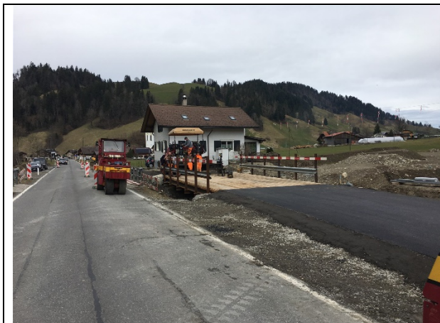
Fertigstellung Notbrücke Rämisbach
