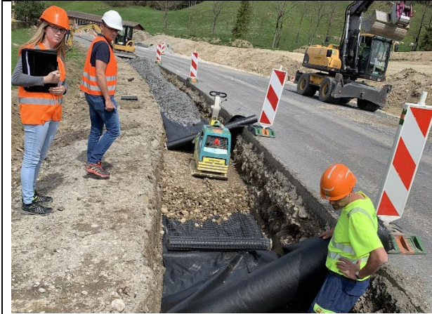
Unterbau der Strassenverbreiterung
