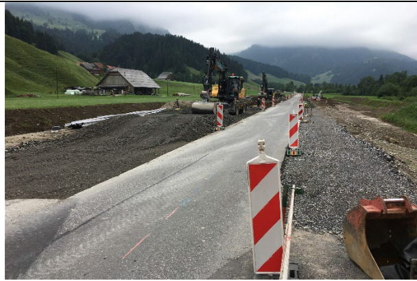
Koffierung Strassenverbeiterung (rechts) und Rad-/Gehweg (links)
