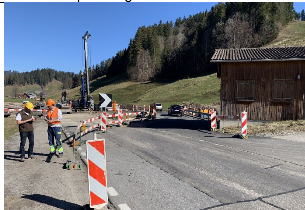
Prov. Rotbachbrücke und Pfahlarbeiten
