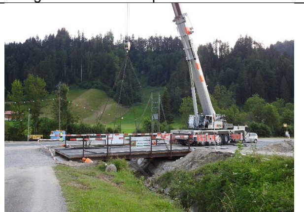
Einbau Notbrücke
