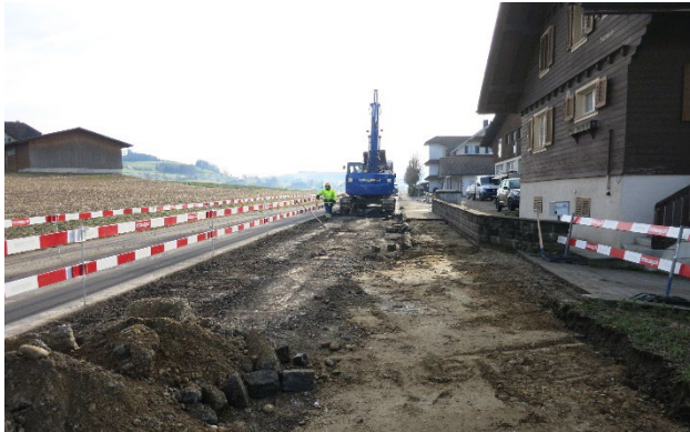
Rückbau alte Kantonsstrasse
