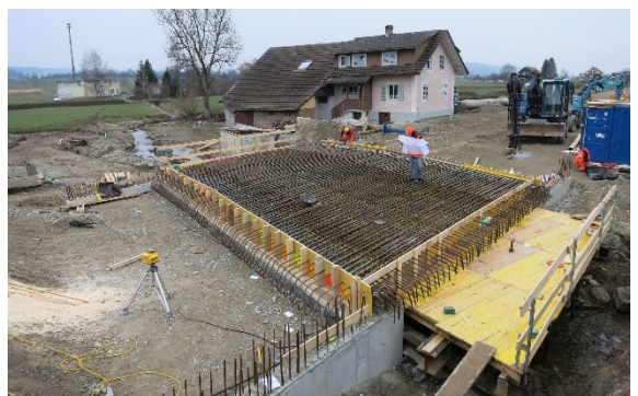
Abnahme Bewehrung neue Tannebachbrücke
