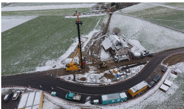
Fundationsarbeiten Tannebachbrücke mit Ver- kehrsumleitung
