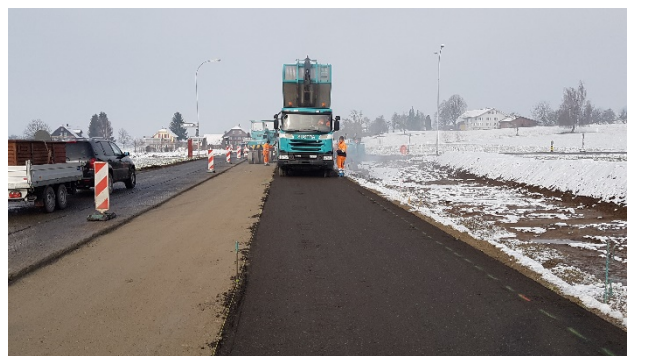
Belagsarbeiten Bereich Abzweiger Unterallmend
