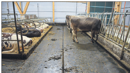
Dank Laufflächen mit 5 % Quergefälle und Harnsammelrinne werden die Ammoniak-Emissionen reduziert.
