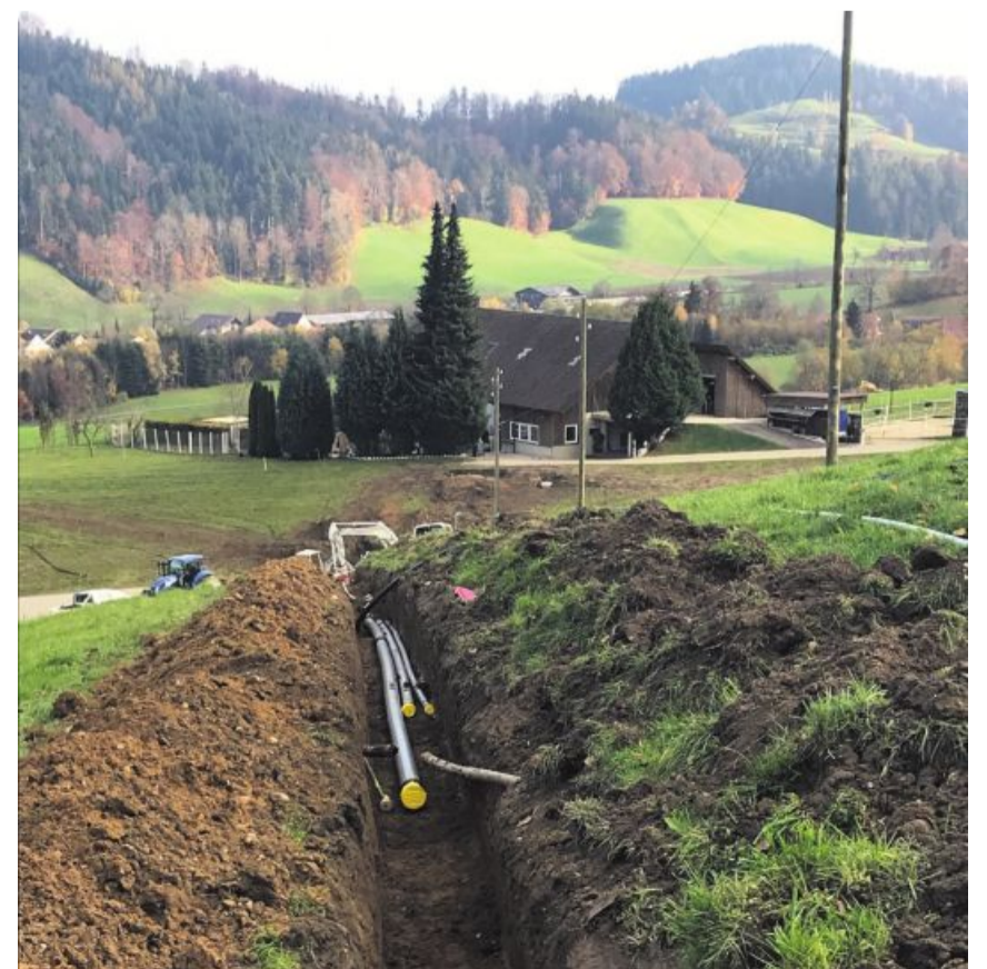
Schritt für Schritt wird in Luthern das Glasfasernetz erstellt. Foto zvg
