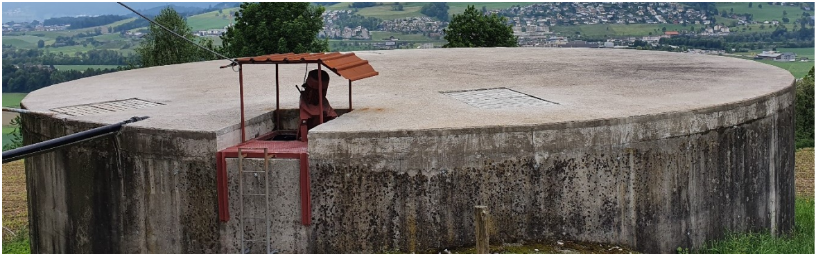
Abb. 5: Feste Konstruktion, Ortsbetondecke. Bild: Dienststelle uwe.
