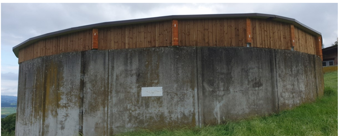
Abb. 3: Feste Konstruktion, individuelle Holzabdeckung oder Stahlkonstruktion. Im Bild zu sehen ist eine bewilligungsfreie Konstruktion mit Firsthöhe < 120 cm gemessen ab Silooberkante. Bild: Dienststelle uwe.
