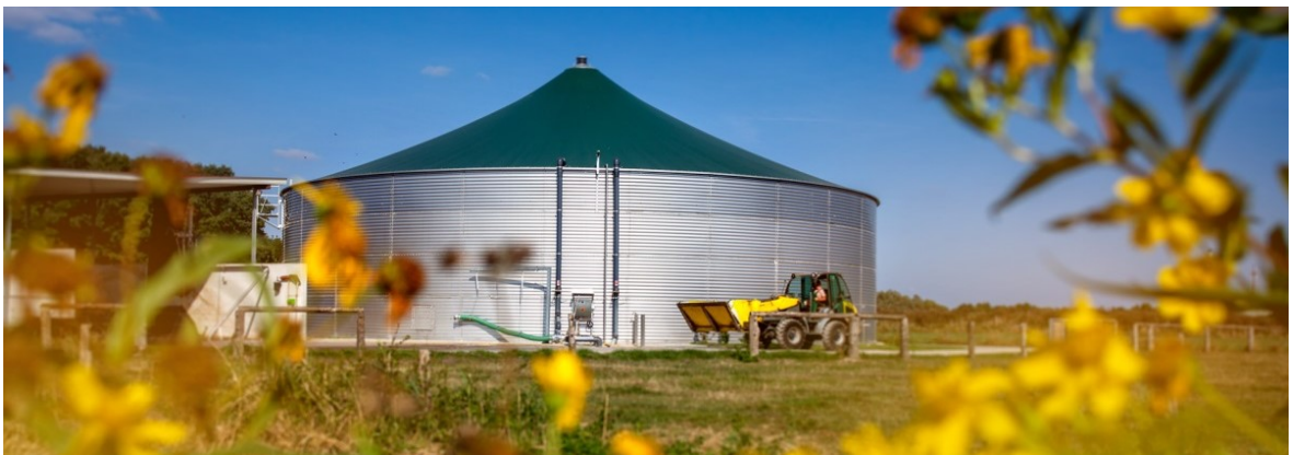
Abb. 2: Feste Konstruktion, Zeldach aus Kunststoff. Bild: ATG GmbH, Gettnau.
