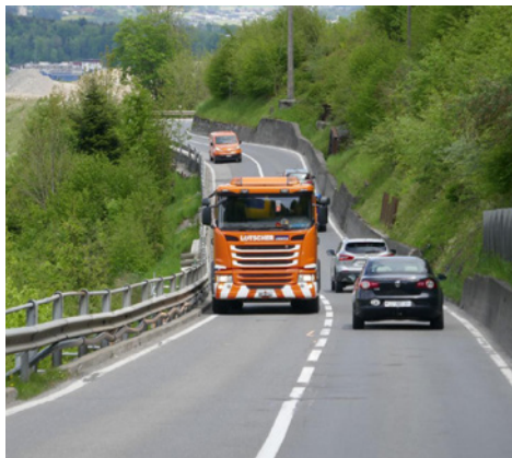
Die enge Rängglochstrasse im Bereich der geplanten Lehenbrücke, Blick Richtung Horüti
