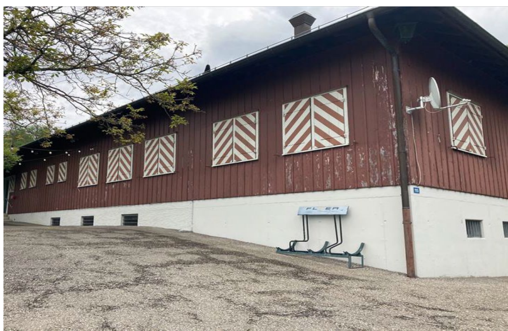
Schiessanlage von aussen in Küsnacht ZH.
